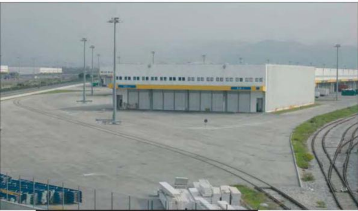
Capannoni Isola 8 (Veduta d'assieme) - Building Area 8 (Front view)
