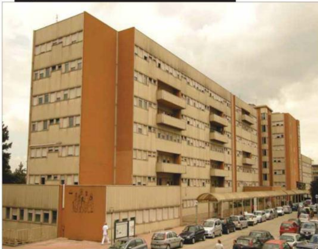
Padiglione "Padre Pio" ex Casmez - "Padre Pio" ex Casmez Building
