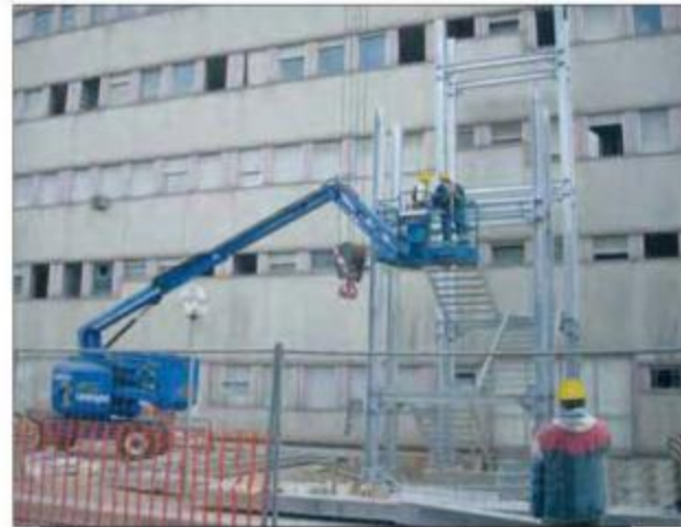
Montaggio scala di emergenza - Emergency exit
